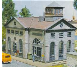
Krachtcentrale „Eisfeld“ Maatschappij: n.v.t. 64
